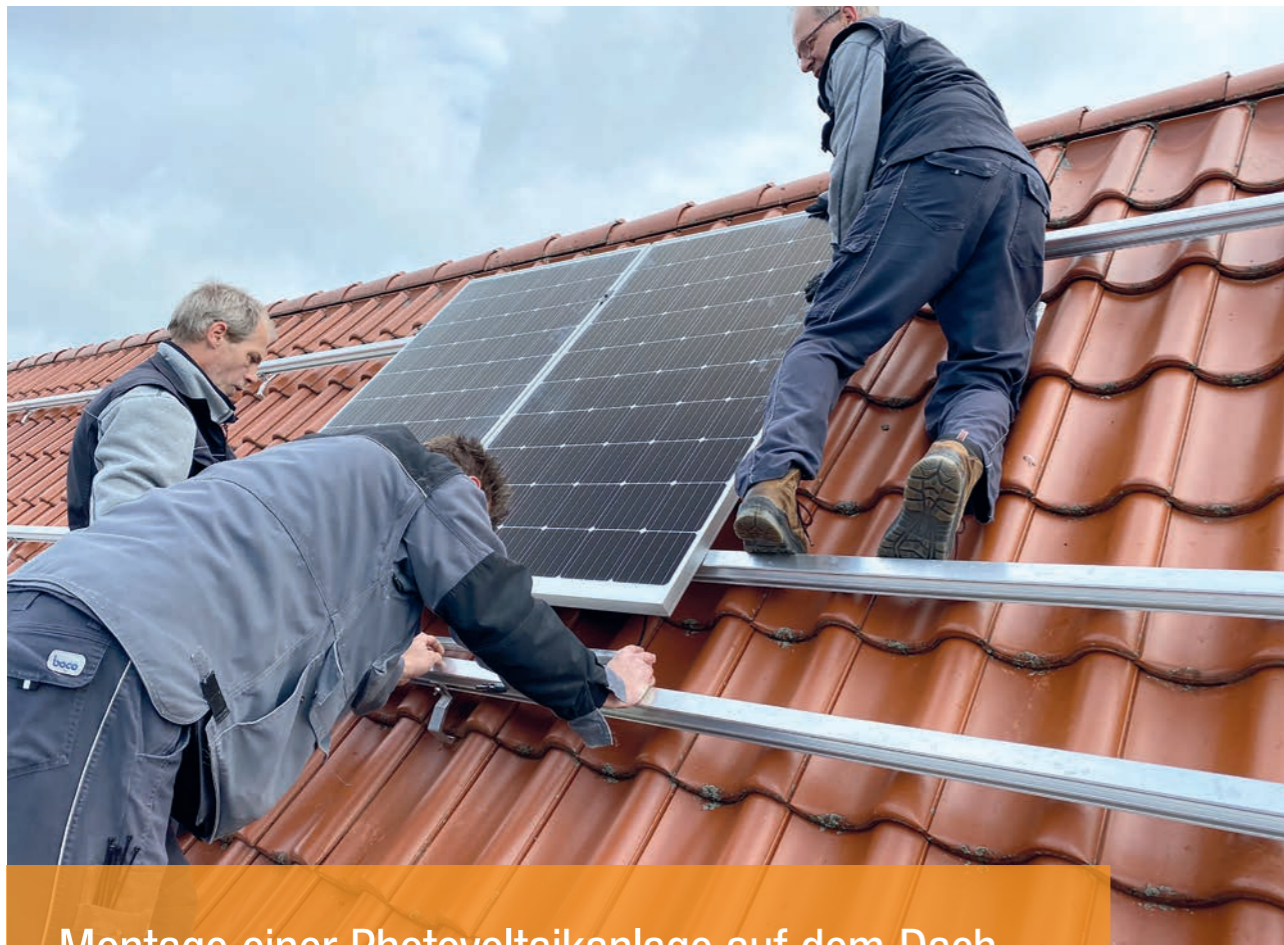
Montage einer Photovoltaikanlage auf dem Dach der Friesenstraße 9A.
