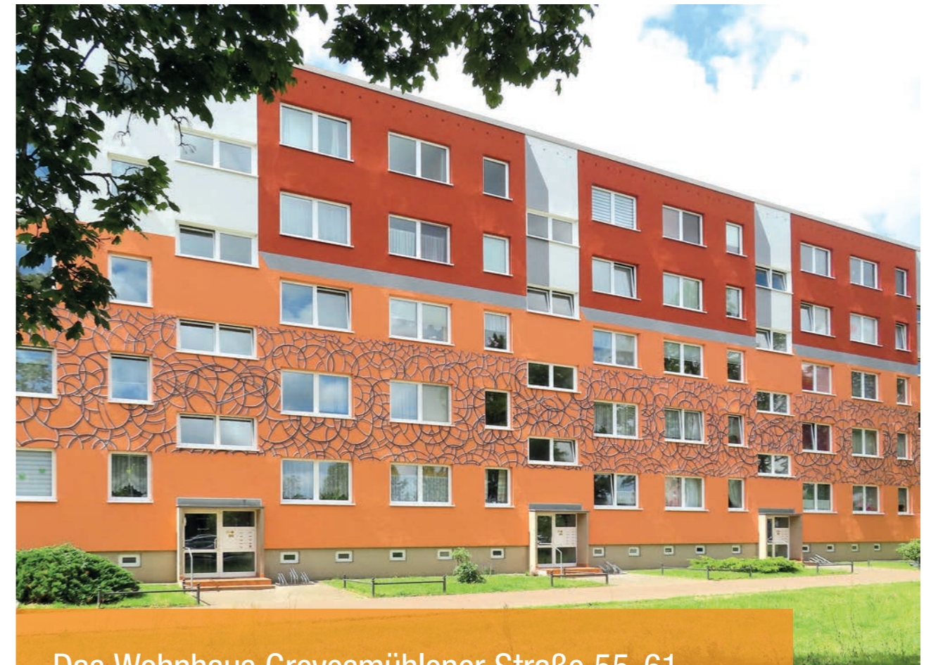
Das Wohnhaus Grevesmühlener Straße 55-61 erstrahlt in satten Rottönen.
