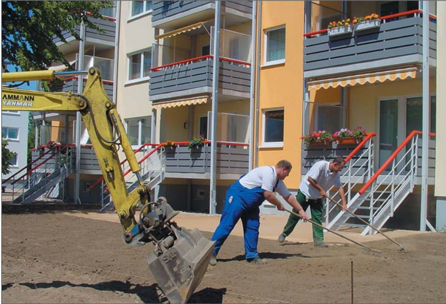
Mitarbeiter der Gartenbaufirma Jolitz gestalten die Außenanlagen am Niedrigenergiehaus
