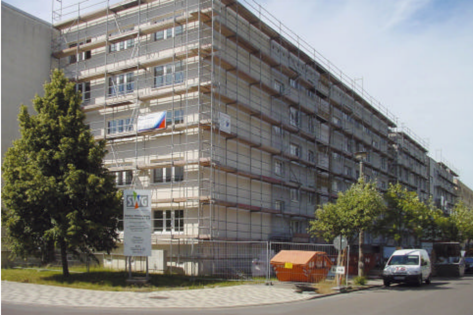
Die Arbeiten in den noch unsanierten Häusern im Wohnquartier Ecke Von-der-Schulenburg-Straße / Max-Reichpietsch-Straße schreiten zügig voran
